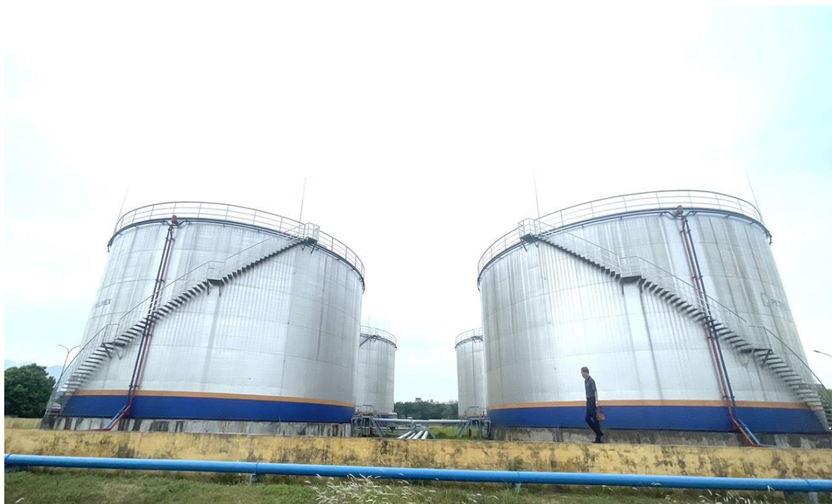
Hình ảnh: Kho Xăng dầu Hà Nam Chi nhánh xăng dầu Hà Nam
